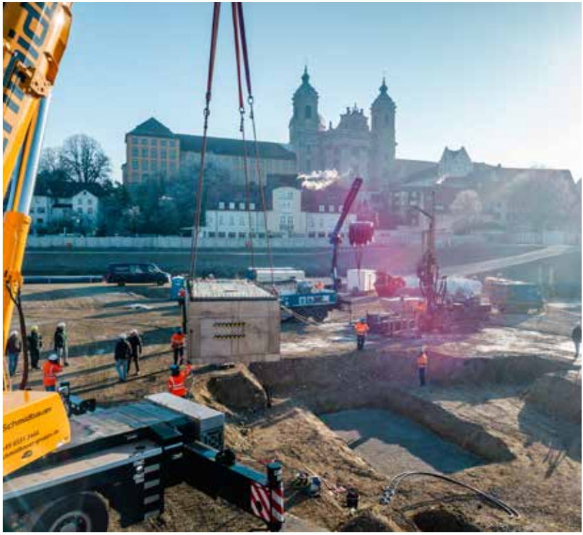
Im künftigen Quartier Martinshöfe entsteht das erste Sondenfeld, die Basis für die klimaschonende Wärmeversorgung. Jetzt wurde ein zentrales Bauteil, der „Sondenverteiler“, eingebaut.
