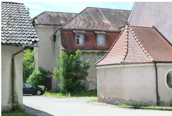
Blick von Norden auf den Gebäudebestand im südlichen Teilbaugbiet mit dem Chor der Kapelle rechts, dem ebenfalls denkmalgeschützten Siechenhaus im Hintergrund und einem Schuppen links im Bild.
