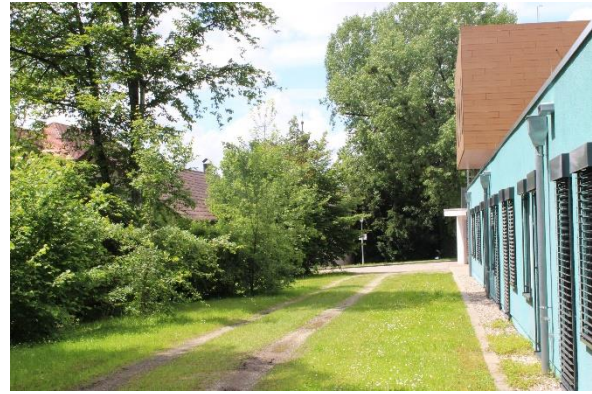
Blick vom südlichen Ausgang des Parks nach Westen, rechts ein Bestandsgebäude des ehem. Krankenhauses, links Gehölzlinie entlang des 14-Nothelfer-Bachs. Im Hintergrund große Pappel an der Kapelle.
