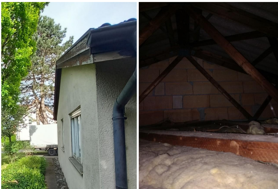
Abbildung 4: Dachbereich des Hauptgebäudes
