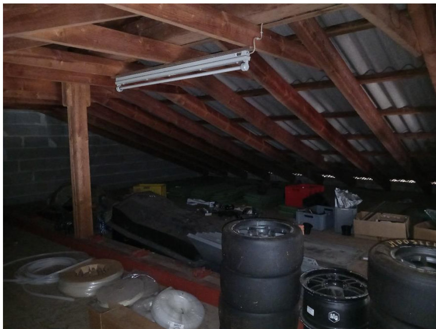
Abbildung 6: Dachbereich des Hallengebäudes
