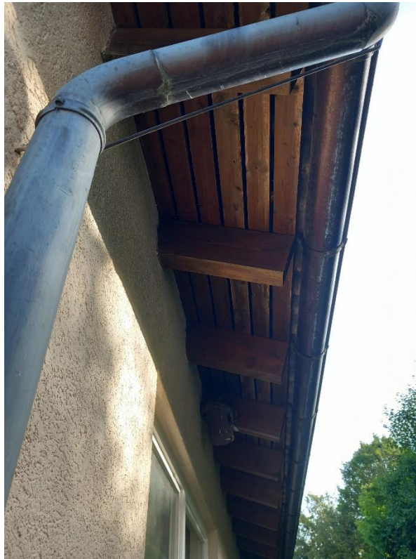
Abbildung 5: Außenbereich des Hallengebäudes, Einflugmöglichkeiten in den Dachbereich und Vogelnisthilfe
