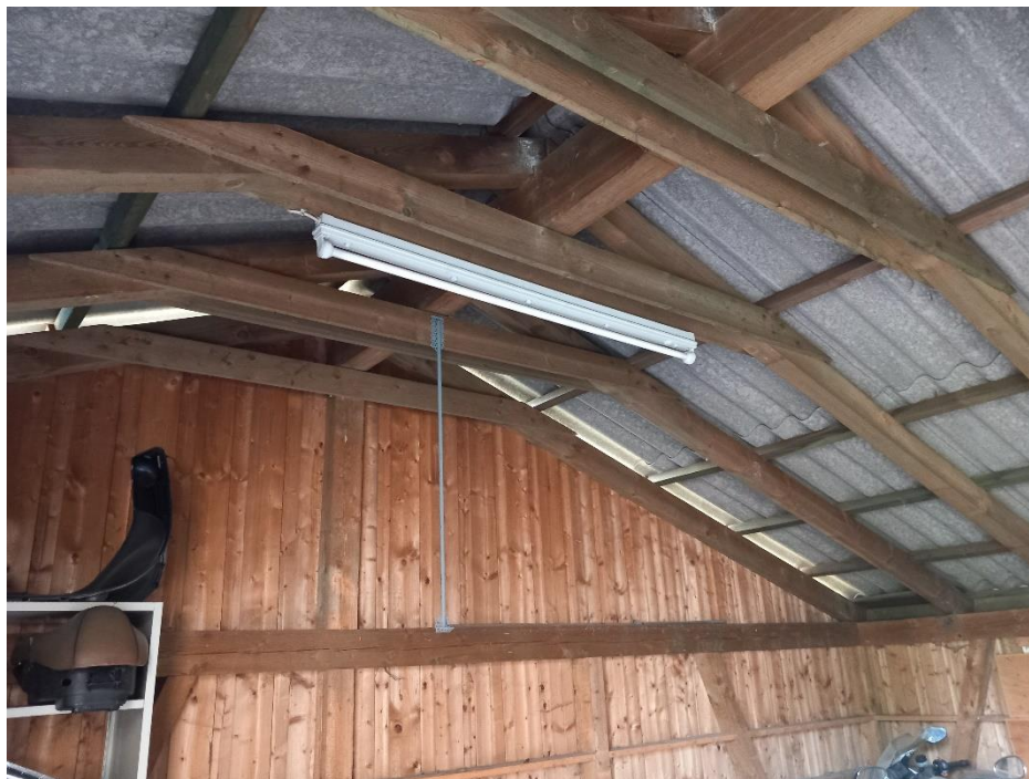
Abbildung 3: Dachbereich der Scheune
